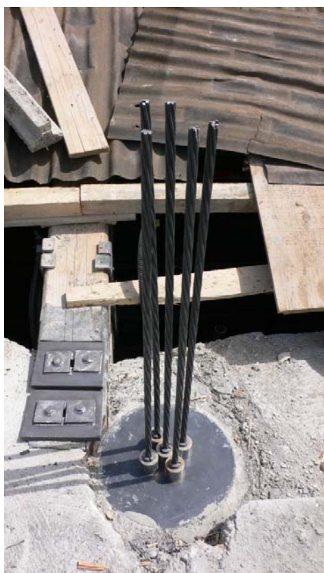
Vista della facciata. Particolare della sommità del muro perimetrale e dell'intirantatura.
