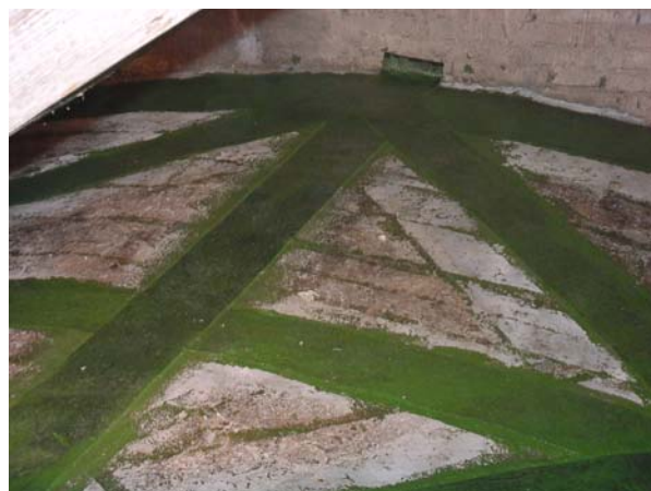
Adeguamento delle volte mediante nastri in composito incollati all'estradosso.
