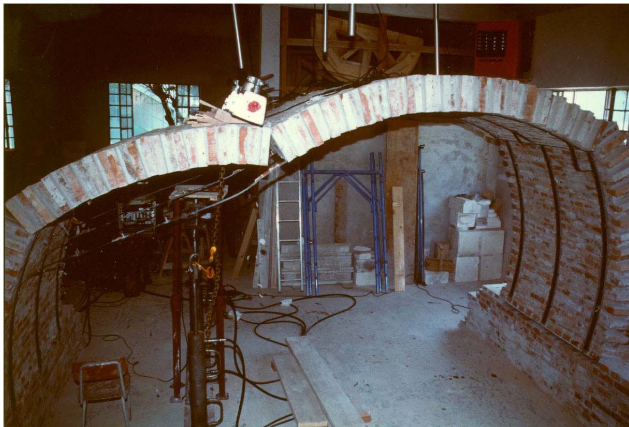
Ponte in muratura, rinforzato in FRP all'intradosso, caricato su una delle reni sino al collasso.
