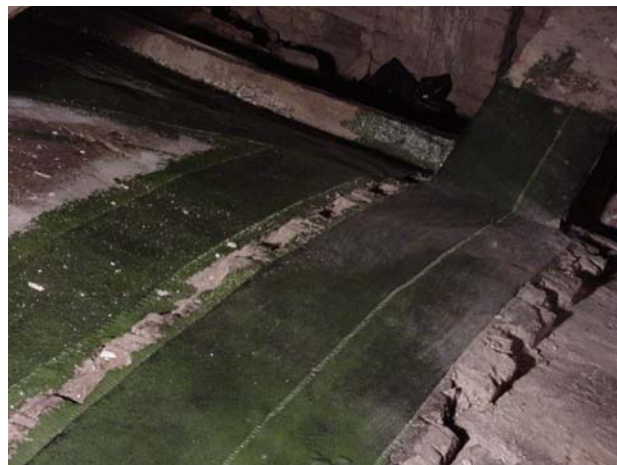
Adeguamento della facciata mediante cucitura del paramento murario all'impalcato voltato.
